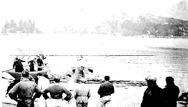
Esperienze di idrovolò a vela compiute nelle acque del Lago di Como nel 1935 con l'aliante «Biancone» munito di «scarponi». I voli sono stati compiuti dal Ten. Gnecco sotto la guida di Vittorio Bonomi, mediante traino fino alla quota di 350 metri, effettuato con un potente motoscafo.
