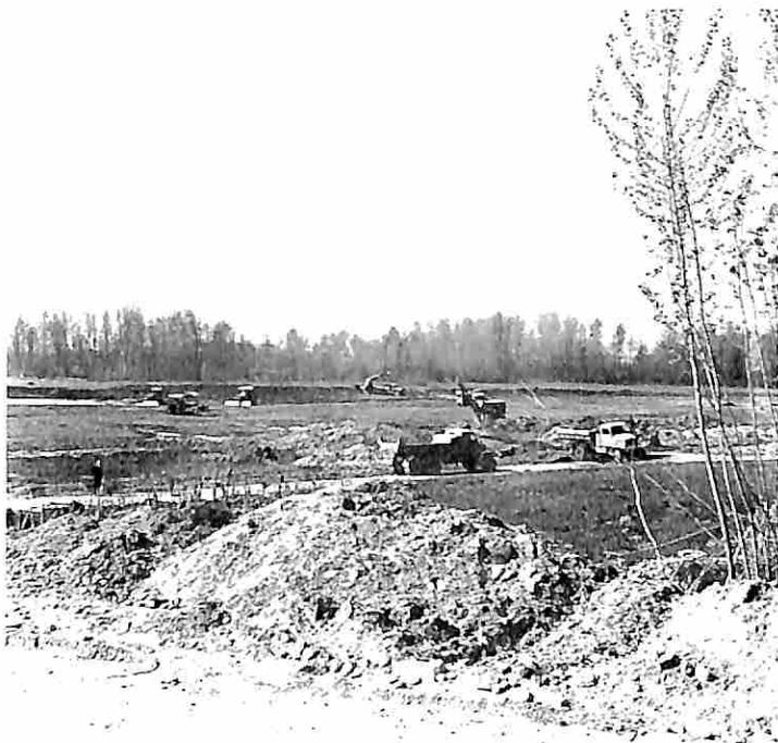
Fig. 19 - Nel 1960, sulle sponde del Lago di Varese, fervono i lavori per la costruzione dell'aeroporto di Calcinate del Pesce, che diverrà ben presto uno dei più importanti centri volovelistici alpini d'Europa.
