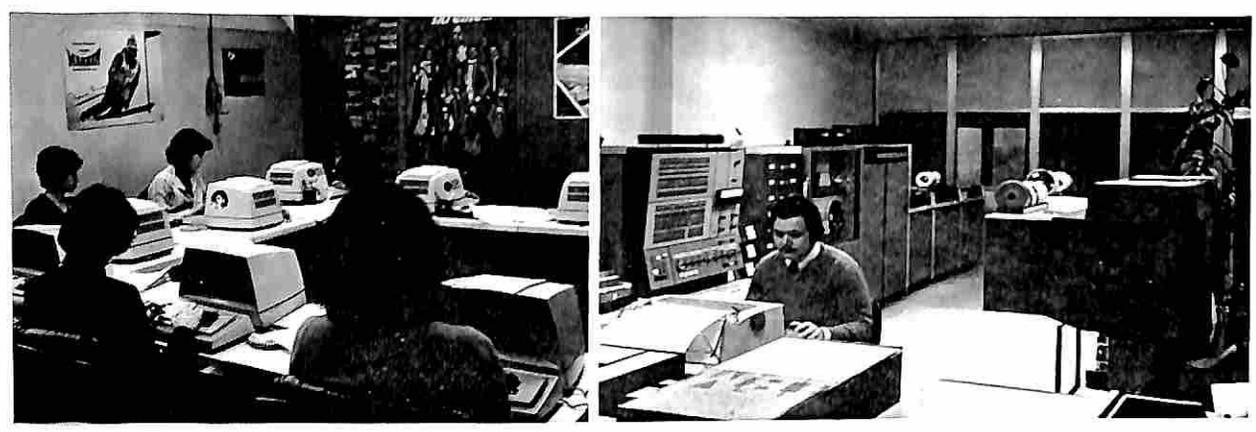
Siamo un centro di elaborazione e organizzazione dotato di 1 Sistema di registrazione CMC, 1 Sistema IBM 360/40, 2 Unità nastro, 7
