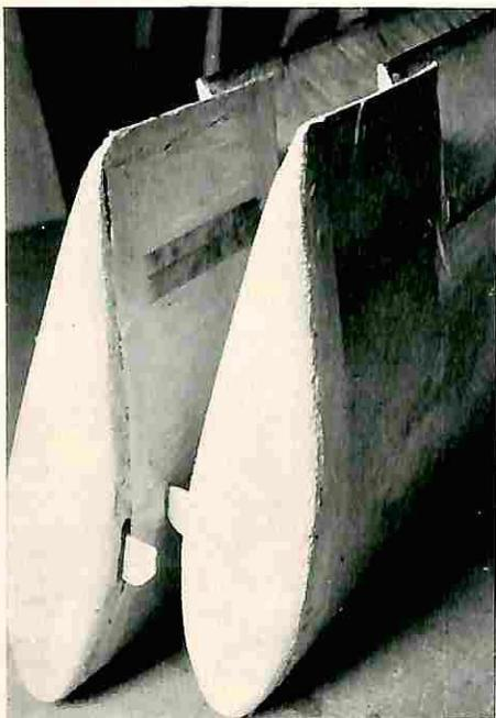
I timoni di coda sono in struttura mista di cellovel irrobustito da listelli e da tela imbevuta di clebofix; il timone orizzontale per questioni di ingombro è smontabile e porta l'ultimo sostegno di irrigidimento della trasmissione per l'elica.
