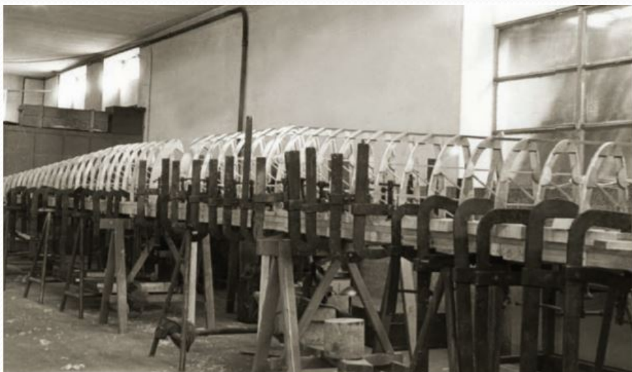
A sinistra: Immagine dello scalo del longherone e relative centine di testata .
