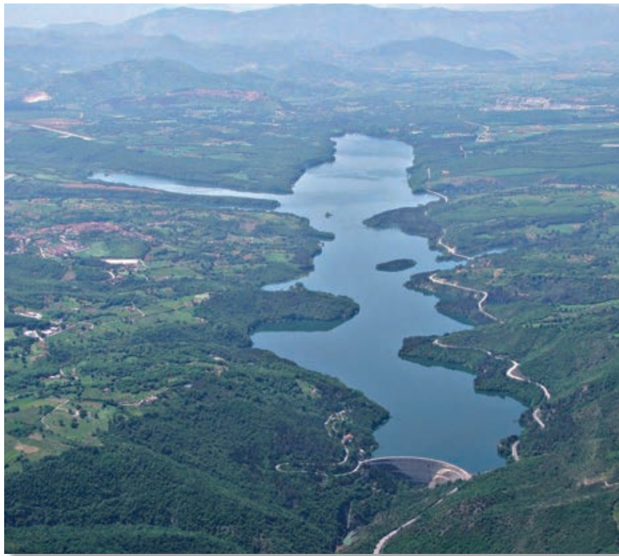
Il lago del Pertusillo, adiacente all'aviosuperficie di Grumento Nova
