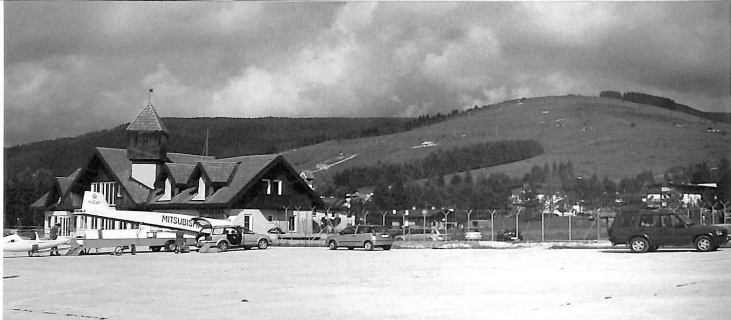
Il piazzale dell'aeroporto e la palazzina in via di ultimazione
