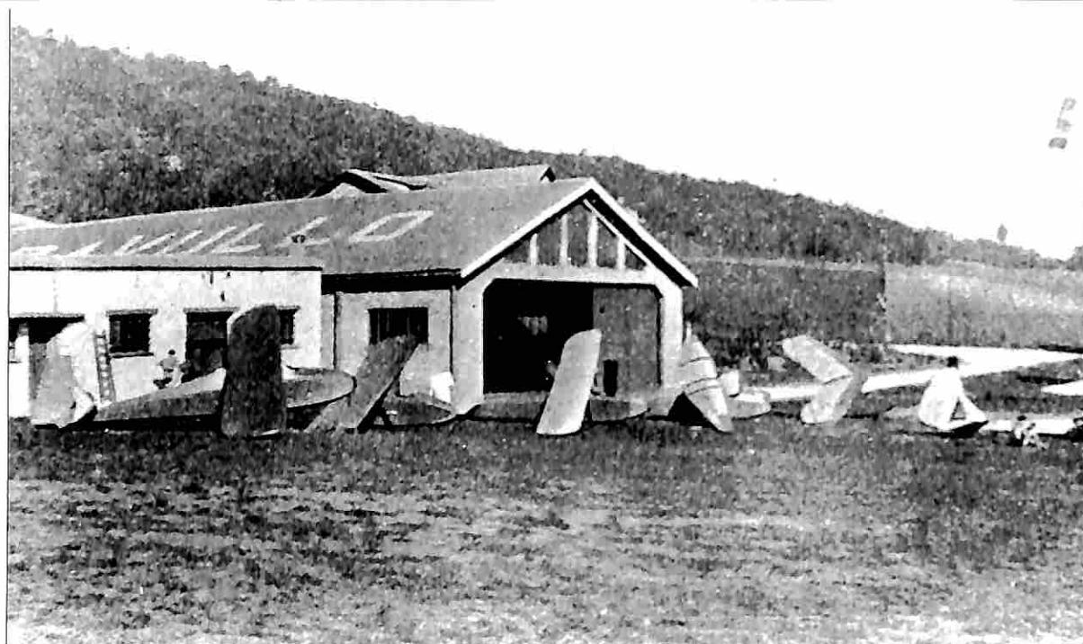
L'hangar dell'aeroporto di Pavullo
