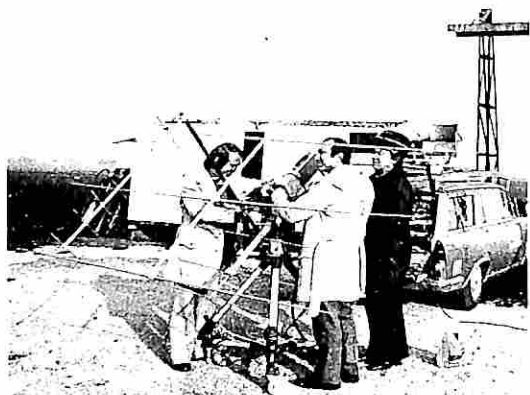
I tecnici della televisione Italiana mentre mettono a punto l'antenna che riceve l'immagine televisiva da bordo dell'aliante
