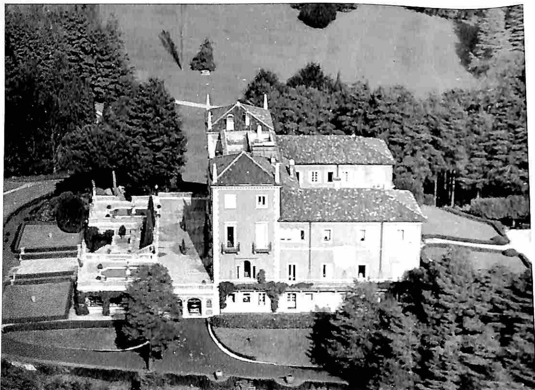
Casciago - Il Poggio Antico, sede del Centro Studi della Bassani S.p.A. - Qui nascono i prototipi degli apparecchi B TICINO
