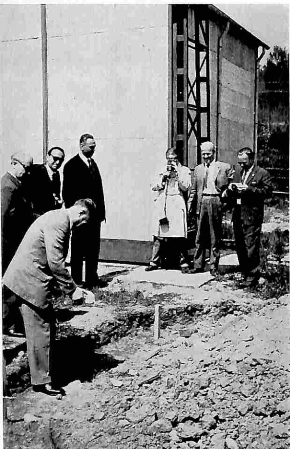
Sull'Aeroporto di Calcinate, il Presidente dell'O.S.T.I.V. Mr. L. A. de Lange procede alla posa simbolica della prima pietra dell'edificio che ospiterà, tra l'altro, l'INTERNATIONAL GLIDING RESEARCH INSTITUTE.
