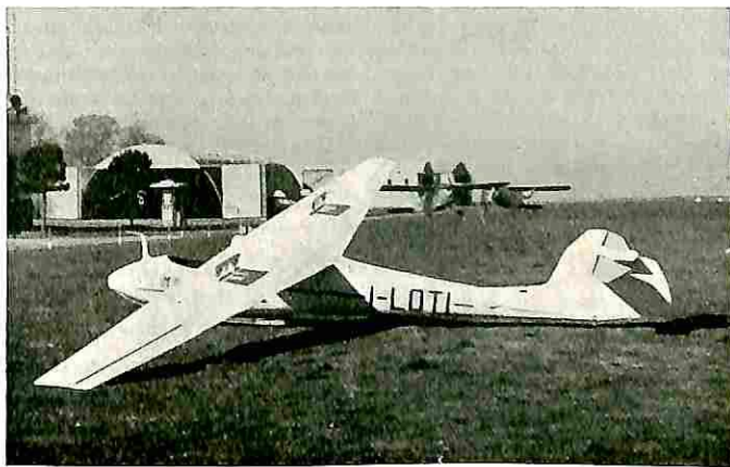
L'M 100 dopo le ultime modifiche citate nel testo. La forma della deriva è stata modificata: è stata tolta la parte sovrastante l'impenaggio orizzontale. L'alettone è stato sostituito con il tipo a fessura. Si notino gli ampi diruttori.
