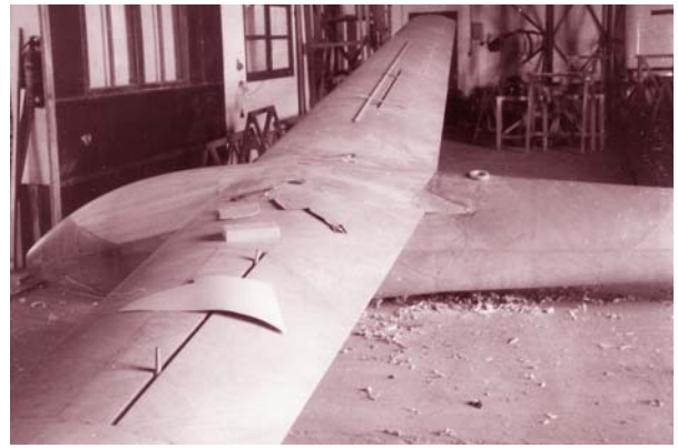
I prototipo dell' Uribel A durante la sua costruzione.
