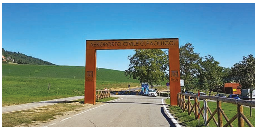
Il nuovo cancello d'ingresso al parcheggio dell'aeroporto nasconde le sbarre retrattili di chiusura. Il metallo è stato ossidato ad arte e poi trattato per preservarne il ricercato aspetto
