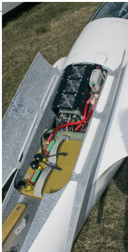
I due blocchi gialli delle batterie, una volta installati e collegati
