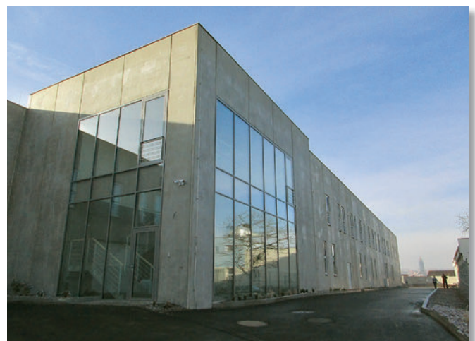
Costruzione in cemento per la migliore stabilità ambientale interna
