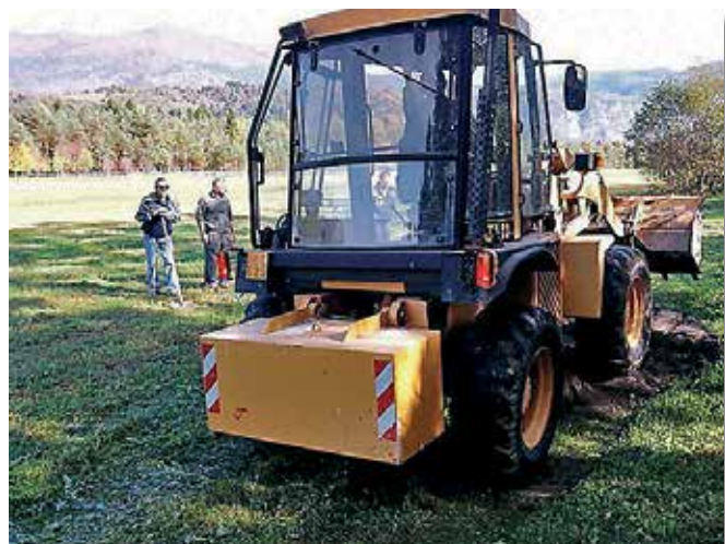
Al lavoro sull'estensione pista
