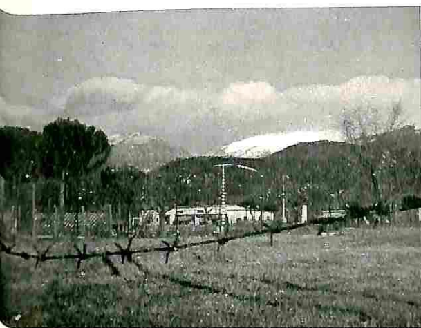
Fig. 2 - Rieti, 27-1-1959 ore 14,23 Muro di Föhn sul Terminillo.
